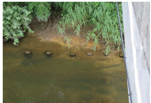
旧最上橋（木橋）の橋脚跡
