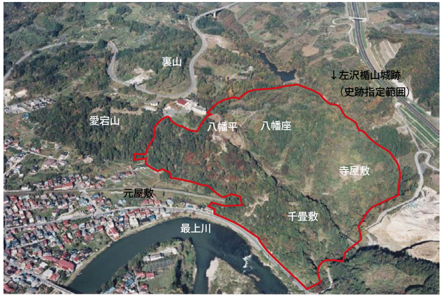
左沢楯山城跡全景 (南東から)
