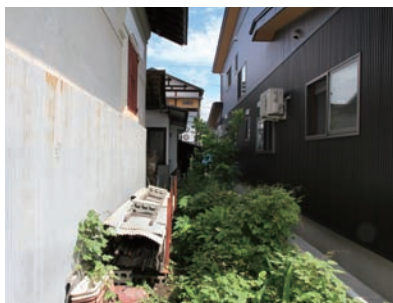
店蔵・住宅・土蔵の並び（奥から）
