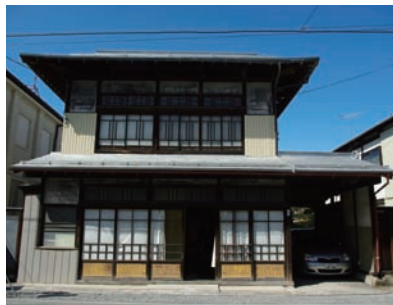
主屋（正面から）
