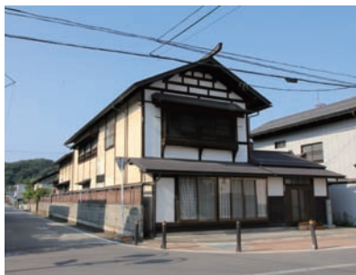
主屋と土蔵（正面から）
