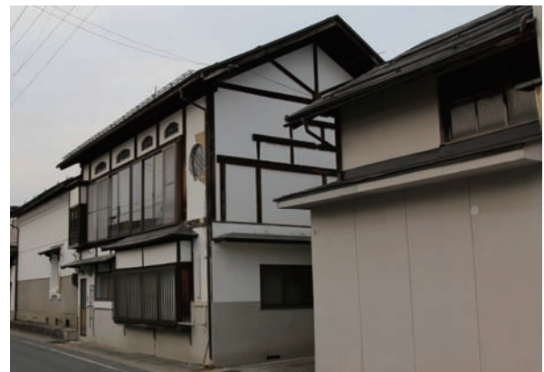
旧廣野家土蔵と住宅建築（住宅側から）
