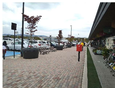
施設前の広場にベンチを設置（道の駅米沢）
