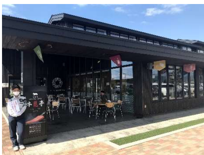
半屋外施設（道の駅米沢）
