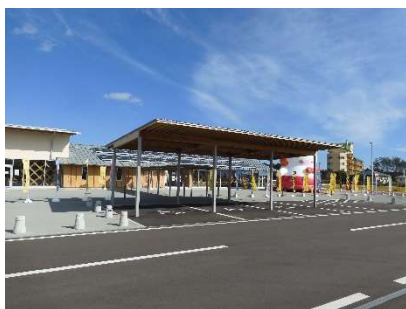
車椅子利用車両用の駐車スペース (道の駅なみえ)
