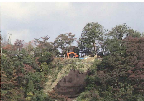
図7 修復された楯山公園南側の崩壊斜面(2014.10) 覆土後種子吹き付け
