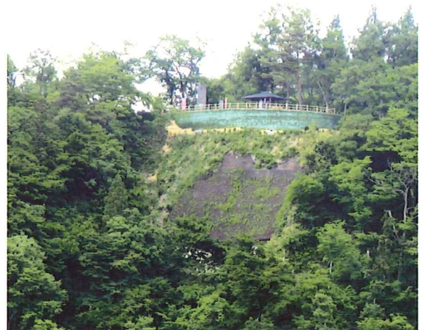
図8 楯山公園南側崩壊斜面の修復後の植生再生状況 (2016.5.13)
