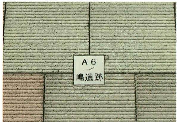
境界標識設置例2 (嶋遺跡)
