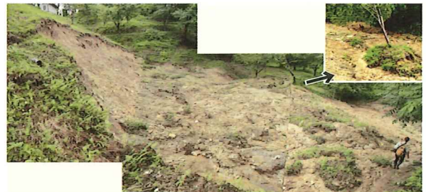
図9 楯山公園北側の大規模地すべり(③型大規模崩壊) 谷埋め盛り土の崩壊・流出(2013.7.26)
