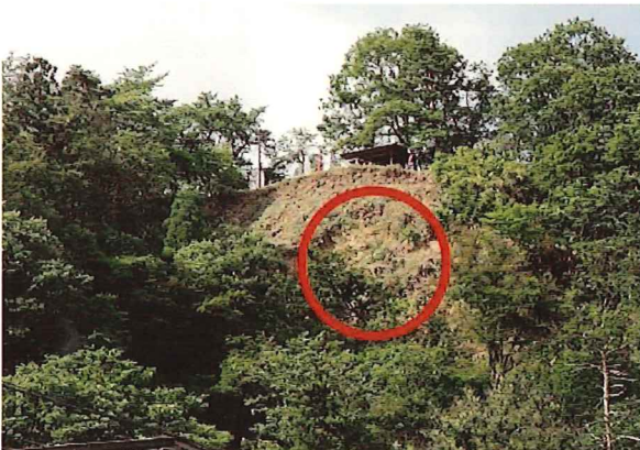
図6 楯山公園南側斜面の②型崩壊(2013.7)
