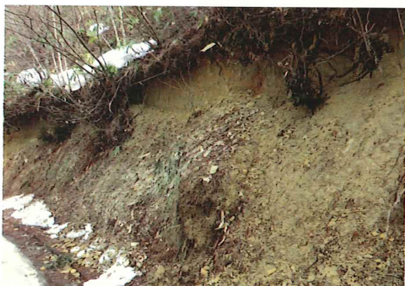
図2 生痕化石を含む浅海性砂岩層の壁面と路側の崩土(楯山公園付近)
