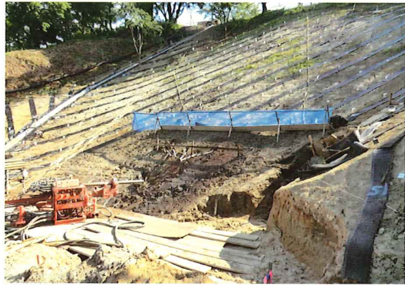
図 12 楯山公園北側斜面 整形、覆土の後、地下水 排出のための水平ボーリング放射状に7本 (2014.6)
