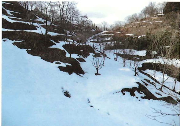
図 14 楯山公園北側斜面の雪解け季の水抜き排水口付近 (2015.3)
